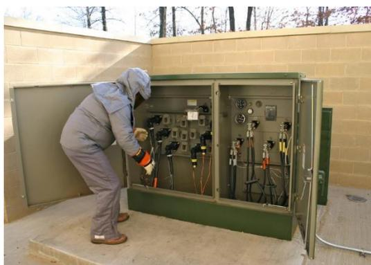
Os terminais desconectáveis tipo plug-in são componentes essenciais nos sistemas de distribuição de energia elétrica, tendo um papel particularmente importante em transformadores de pedestal. Eles proporcionam uma conexão prática e segura entre o transformador e a rede, sendo uma solução padronizada adotada pelas concessionárias de energia.
